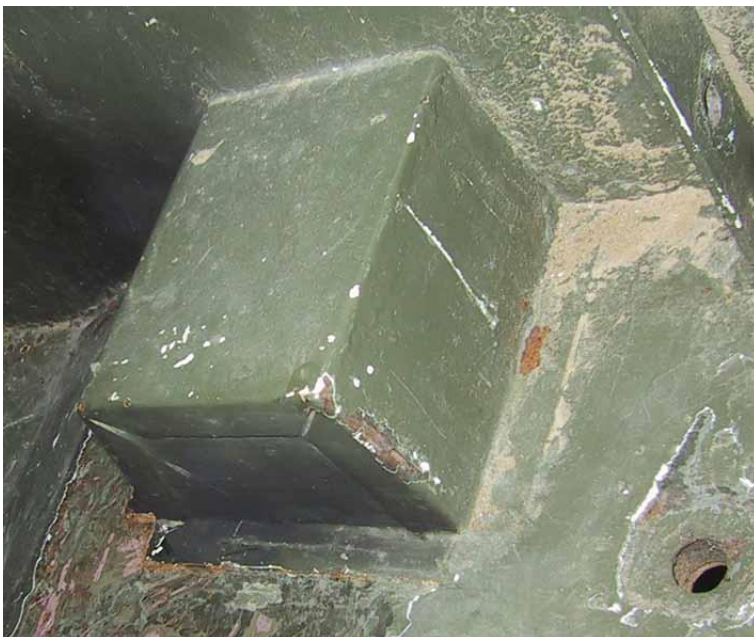
VUE D'ENSEMBLE DU COFFRE
